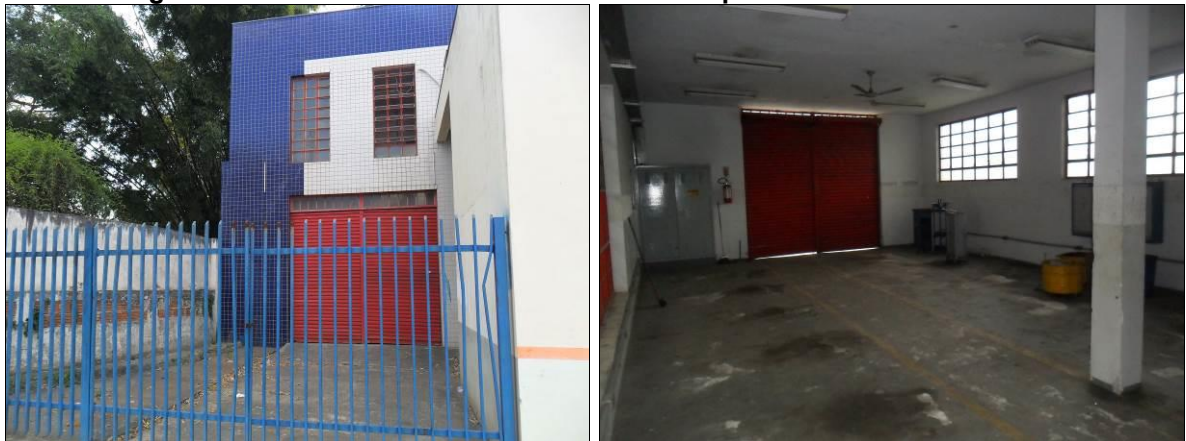
Figura 78: Vista externa e interna do futuro ecoponto de eletroeletrônicos.
