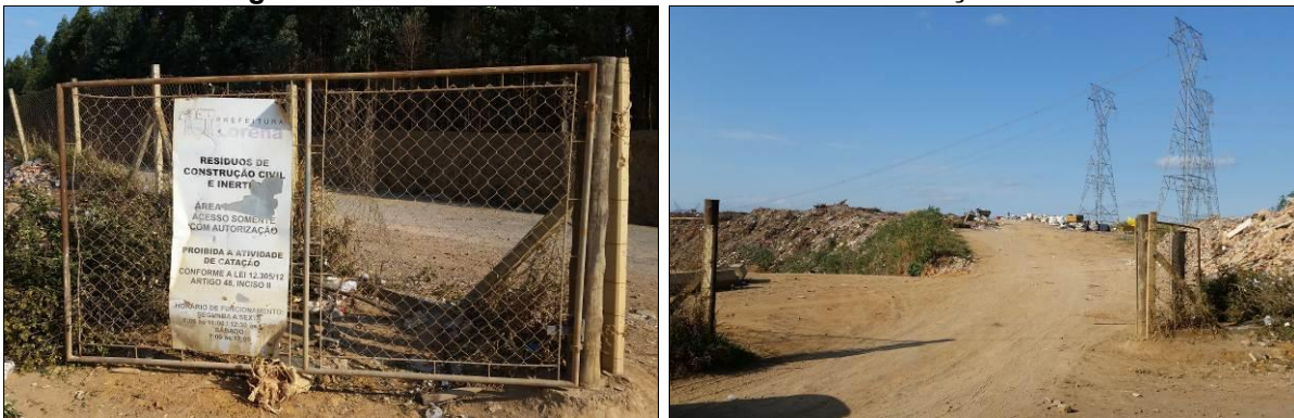
Figura 62: Entrada do aterro de Resíduos da Construção Civil.
