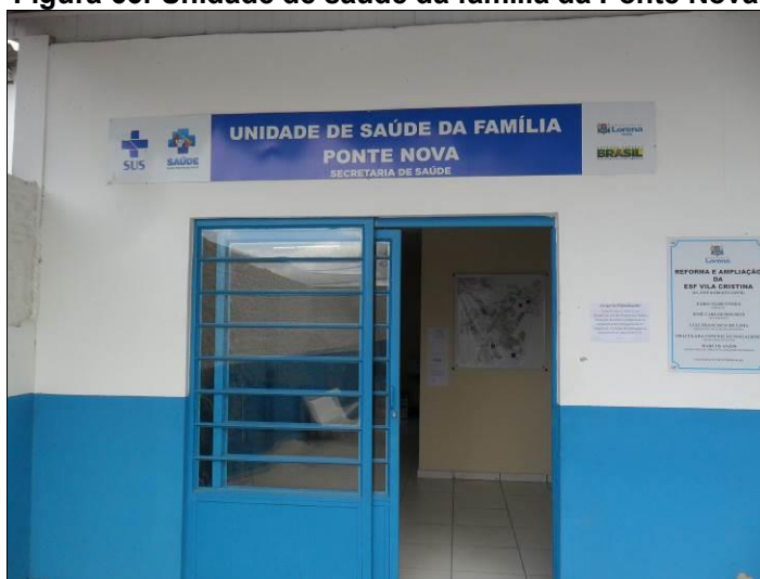
Figura 66: Unidade de saúde da família da Ponte Nova.
