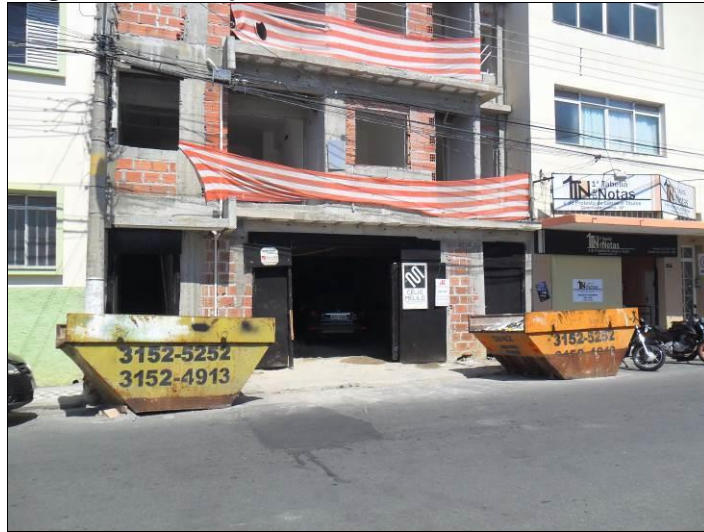
Figura 59: Exemplo de caçambas de RCC em Lorena.
