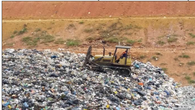
Figura 43: Resíduos sendo compactados na célula em operação.
