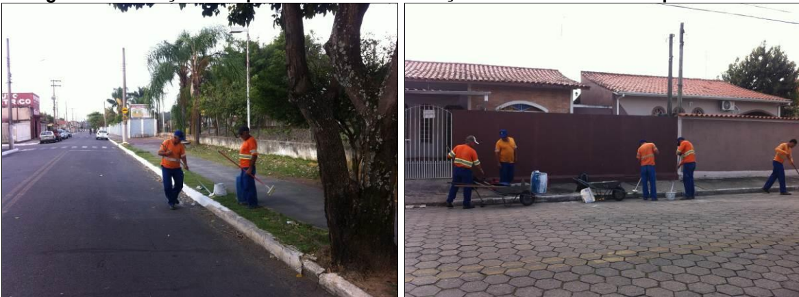
Figura 49: Serviço de limpeza de meio-fio e caiação sendo executado empresa EPPO.
