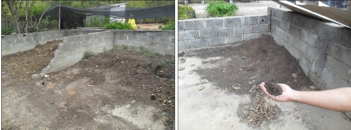
Figura 53: Baias para a compostagem de resíduos verdes.
